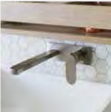
面盆水龙头 哑光镀铬墙砖 水龙头和出水口
